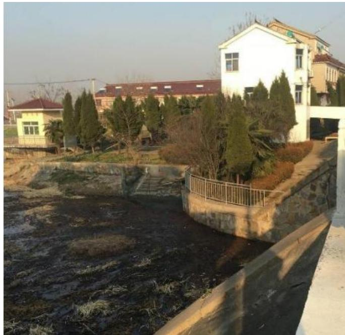
图 2-3 上游浆砌石护坡破损严重
