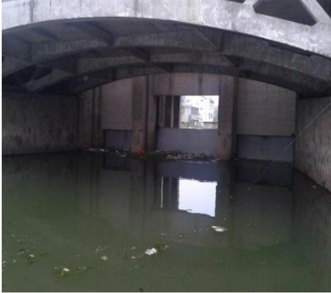
图 2-2 中孔 5m，不能满足渔政执法船安全通航要求；平面钢闸门水下部分锈蚀
