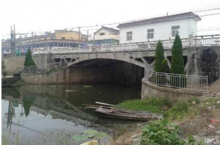
图 2-1 下游翼墙砼勾缝及砼盖顶破碎；下游护坡破损
